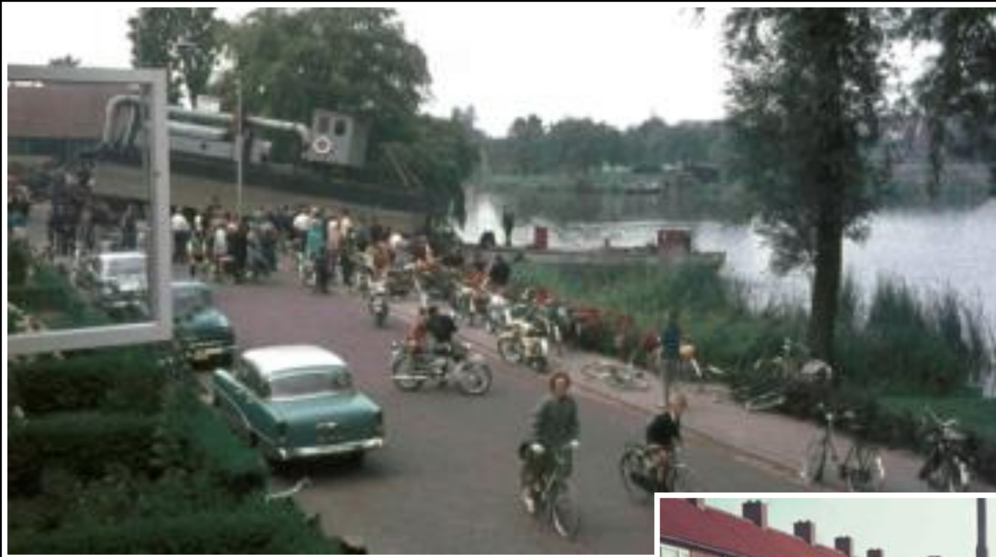
1969, achter het gemeentehuis (Prins Bernhardstraat) wordt een baggerschip te water gelaten in de Waal.
