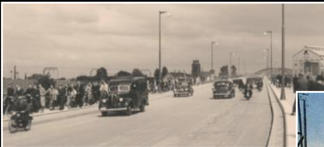
De opening van de brug in 1939, kijkend richting Dordrecht.
